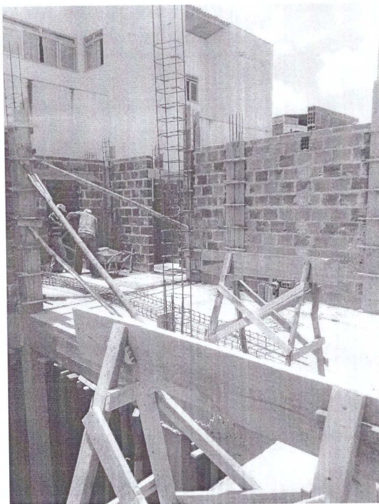
Foto 05 – Alvenaria e estrutura 1º Pavimento
